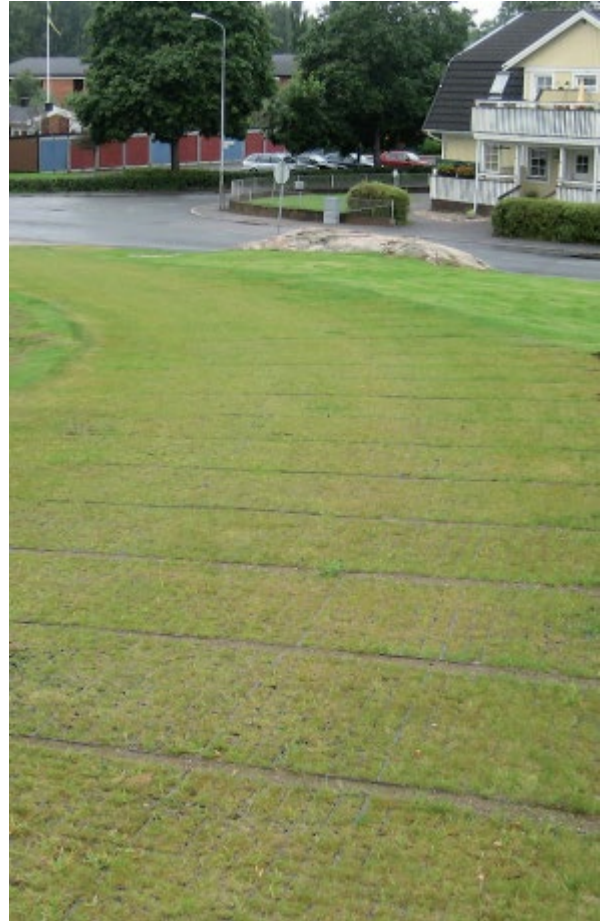
Figur 12: Standardarmering med gräs för brandväg (Veg Tech AB) © Veg Tech AB
