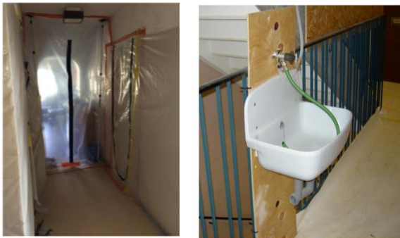
Figur 2.11 Dammspärrear som sätts upp för att förhindra dammspridning i lägenheten. (Riksbyggen, 2019). Återgiven med tillstånd.
