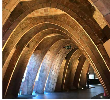
ROOF SKELETON Casa Milà, Barcelona
