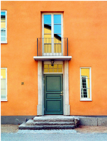
Bild: Brunnberg/Forshed. Fasad och entré till trapphuset
