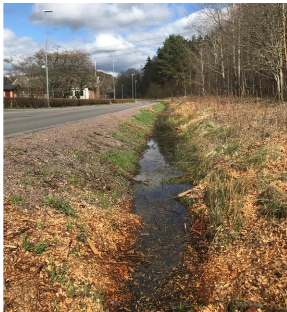
Figur 9 Svackdike där vattnet står kvar trots flera dagar utan regn. Underhåll i form av rensning av diket behövs. Egen bild.
