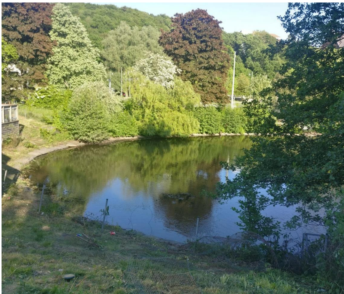
Figur 8 Fördröjningsdamm där flack lutning och inhägnad går att se. Egen bild.
