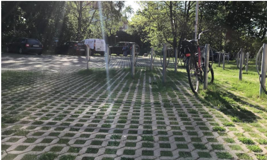
Figur 7 Genomsläpplig beläggning på yta för cykel- och bilparkering. I övre högra hörnet på bilden går det att se att gräset har växt ur hålrutorna och sprider sig över ytan vilket förhindrar ytans funktion att låta vattnet ta sig ner genom hålen. Skötsel i form av rensning behövs. Egen bild.
