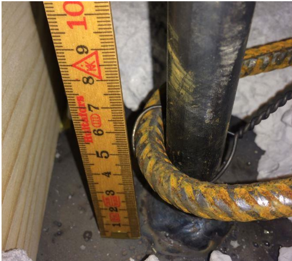
Figur 4.4 Kontroll av bygelplacering höjddled. Foto av författarna.
