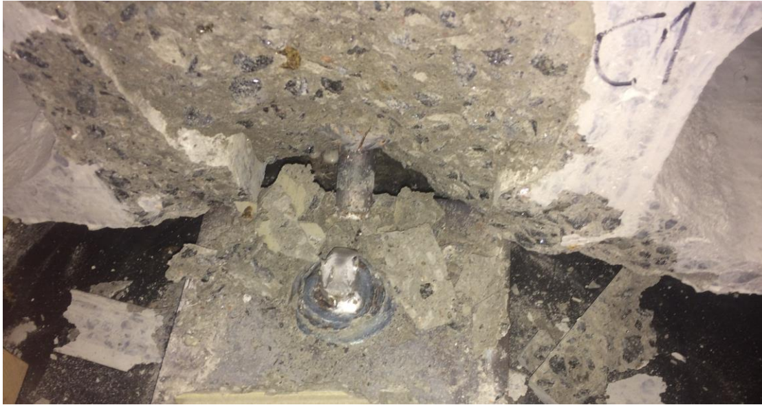
Figur 5.8 Brottyta dubb C1. Betongen har spjälkats bort och ett kombinerat skjuv/böjbrott har skett i dubb. Foto av författarna.
