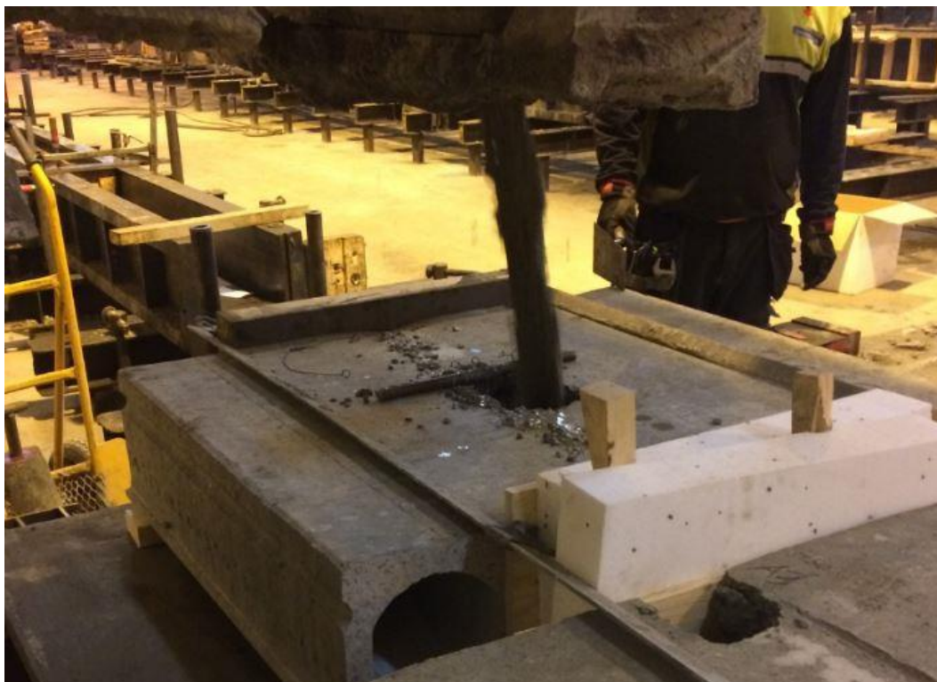
Figur 4.6 Ingjutning av håldäckskanal. Foto av författarna..
