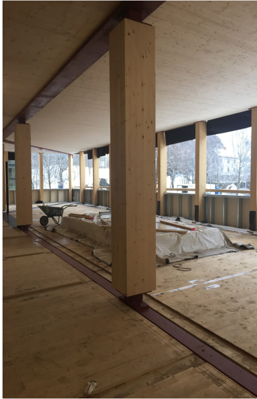
Figur 7.11. Upphöjd limträpelare på pelarfot av stål i JSP2. Författarnas egna bild.
