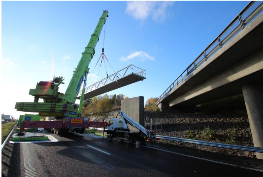
Figur 4.4: Fackverksbro i ett spann lyfts på plats (Sandberg, 2018). Återgiven med tillstånd.
