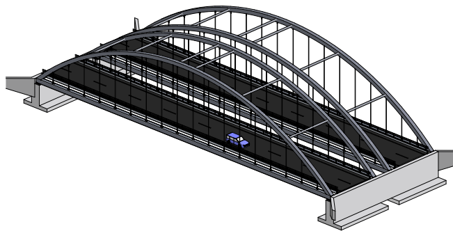
Figur 7.1: Bild på den planerade bågbron i stål
