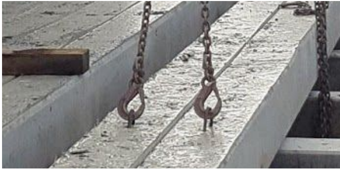
Fig. 2.4. Pålarna är idag kopplade med kätting och hake som fästs i pålens krokarna.
