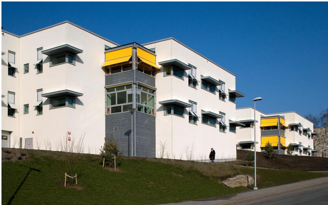
Bild 5.3 Allmänpsykiatri SU/Östra sjukhuset
