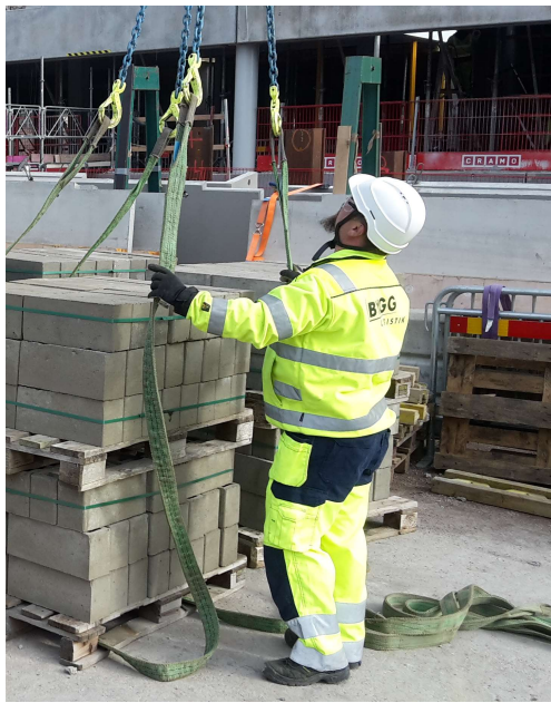
Figur 1. Förberedelser inför kranlyft
