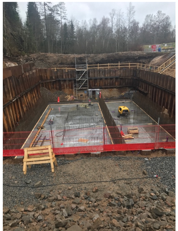
Figur 7. Schaktning för Gäslösspumpstation, Borås. Författarens egen bild
