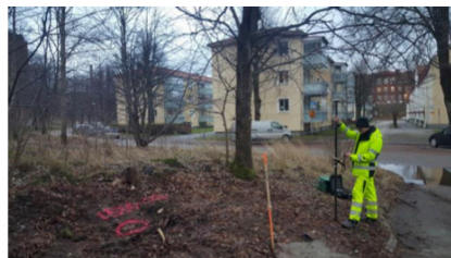
Foto 1. Provgrop 15WC4581, orienterande bild. Direkt bakom mättekniker ses Dalbogatan.
