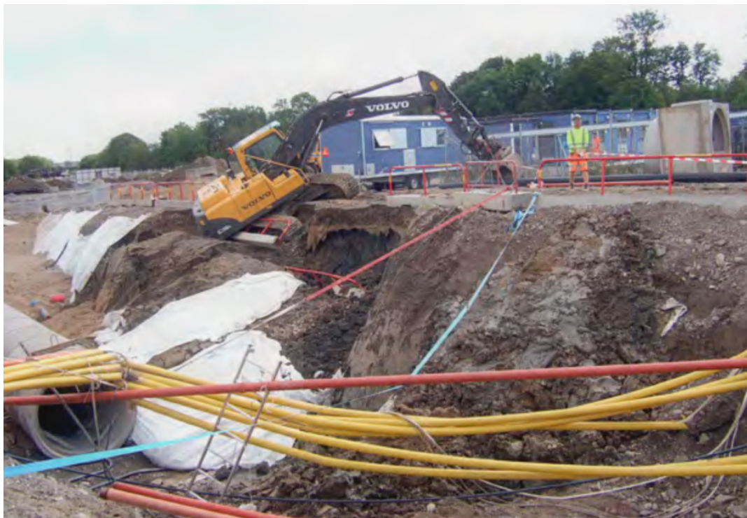
Figur 9. Schakten har rasat på grund av för brant lutning (Schakta säkert, 2015).
