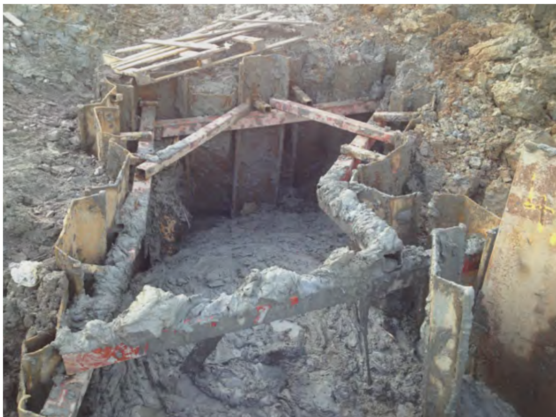
Figur 10. Spontkonstruktionen har kollapsat på grund av för liten konstruktion (Schakta säkert, 2015).
