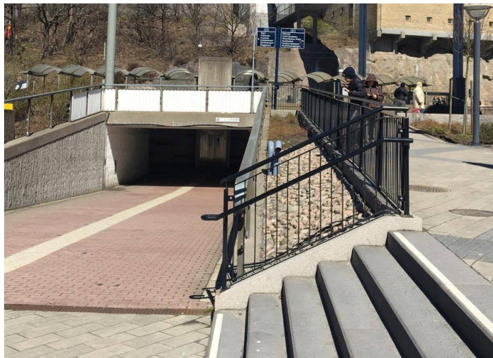
Figur 3. Gångtunnel vid Per dubbsgatan. (Hanna Aspfors, 2017).
