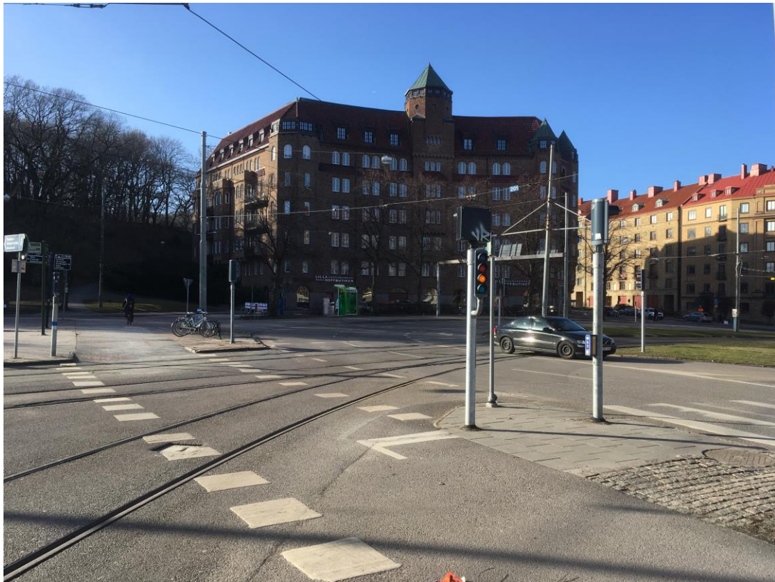
Figur 3.10, Spårövergång vid hållplats, Linnéplatsen. Författarens egen bild.
