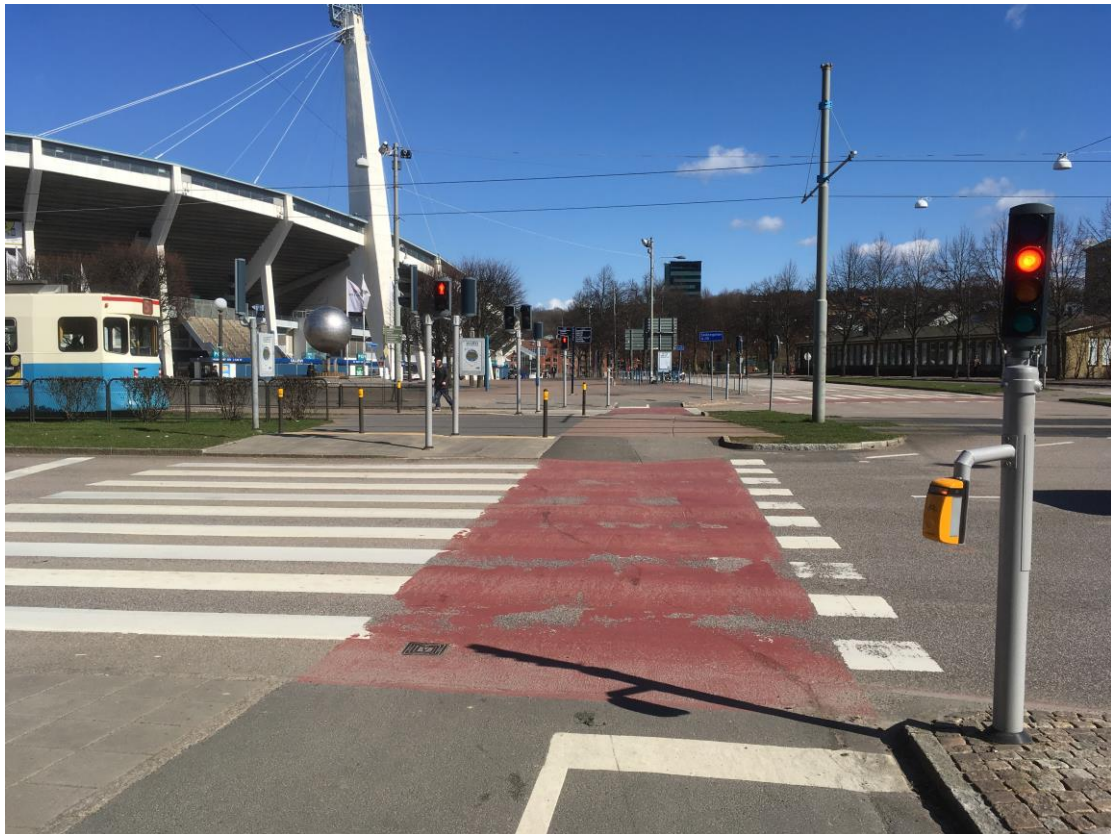
Figur 3.8, Spårövergång vid hållplats, Södra Ullevi. Författarens egen bild.
