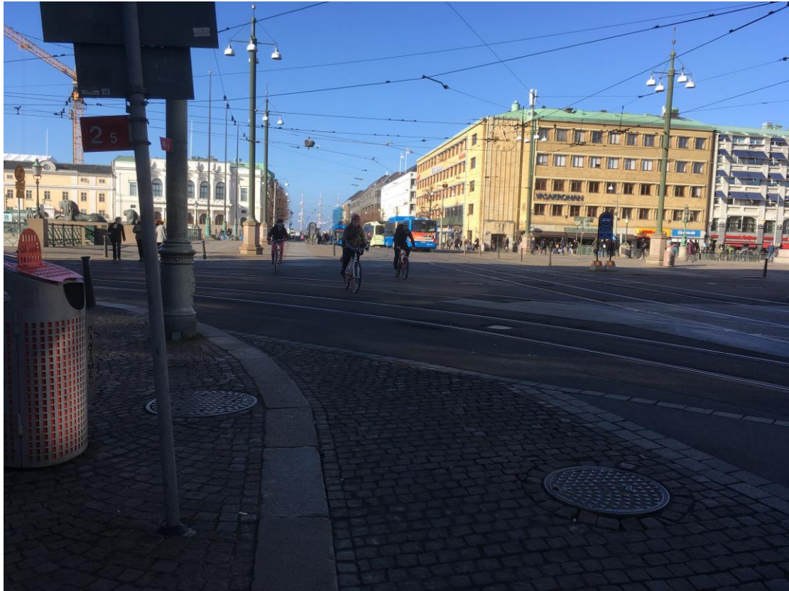
Figur 4.24, Spårövergång vid hållplats, Brunnsparken. Författarens egen bild.
