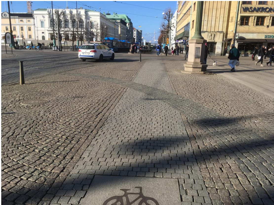
Figur 3.12, Spårövergång vid hållplats, Brunnsparken. Författarens egen bild.
