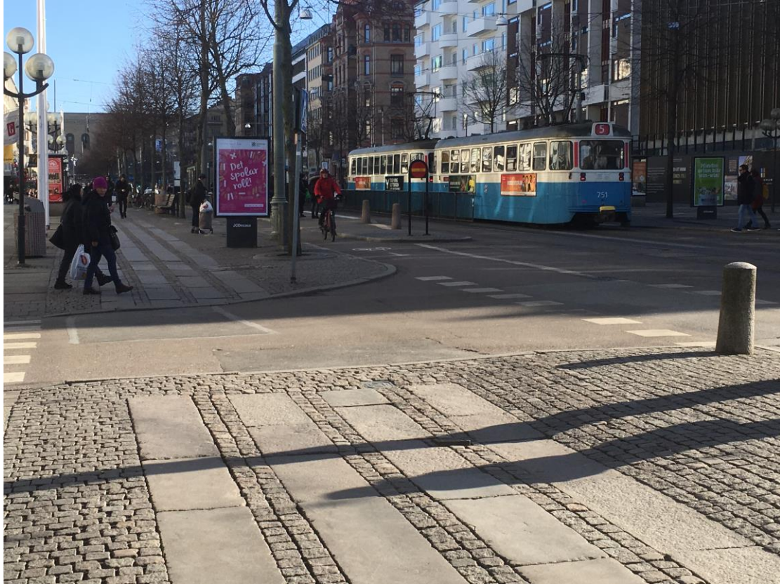
Figur 4.25, Spårövergång vid hållplats, Valand. Författarens egen bild.
