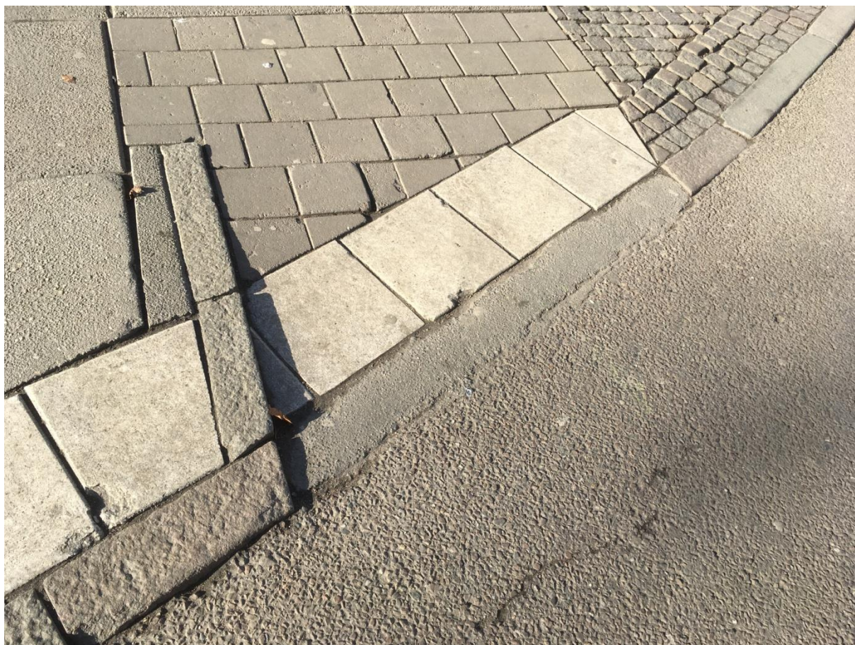
Bild 2. Nollad kant, Avenyn. (2017-03-15). Författarens egen bild.
