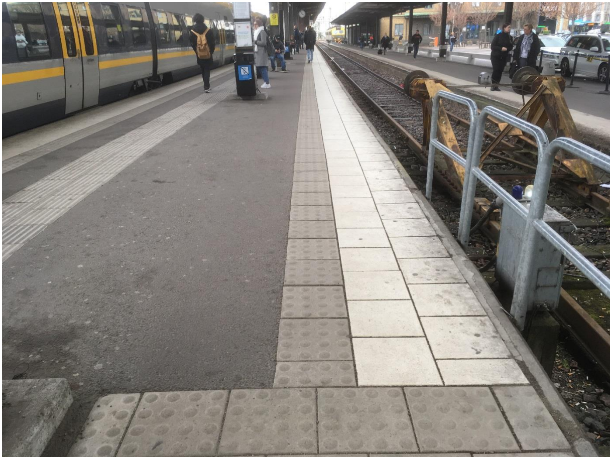
Bild 14. Kupolplattor, Centralstationen Göteborg. (2017-04-25). Författarens egen bild.
