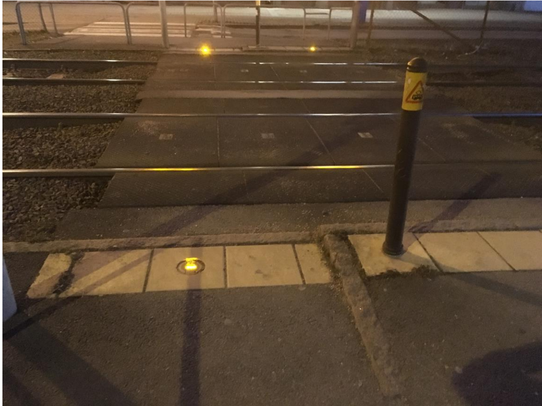
Figur 4.27, Spårövergång, Masthugget. Författarens egen bild
