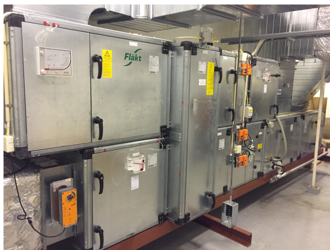
Figur 3.2 Bild på aggregat LB02. Författarens egen bild.
