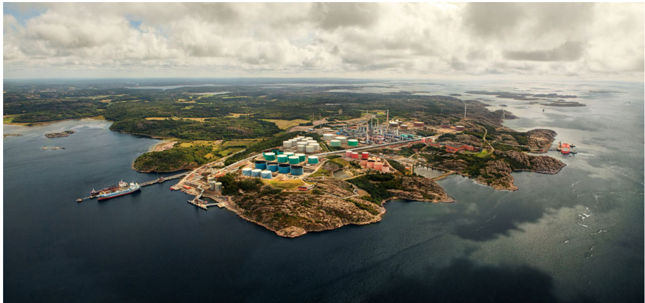
Raffinaderianläggningen på PREEM Lysekil.
