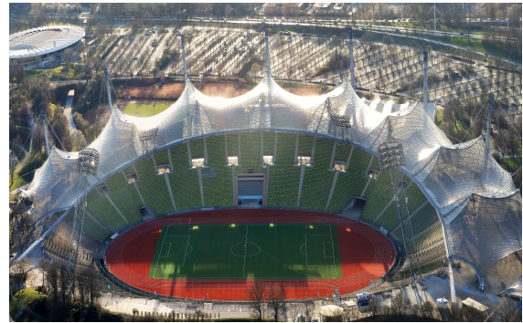
Figur 1-2 – Olympiastadion i Münchens tak är ett exempel på hur linbärverk kan kombineras till ett större kabelnätverk.
