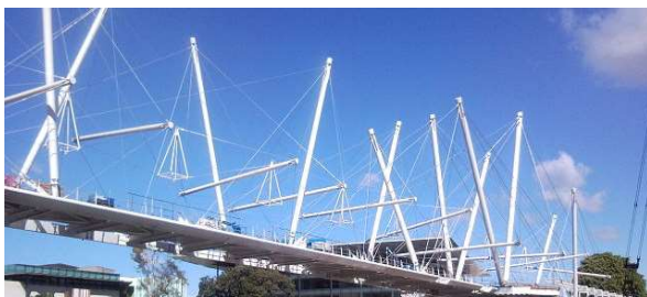
Figur 1-3 – Kurlipa Bridge i Brisbane är en tensegritystruktur.
