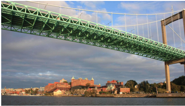
Figur 1-1 – Älvsborgsbron i Göteborg är ett exempel på hur linbärverk kan kombineras med fackverk i en konstruktion.
