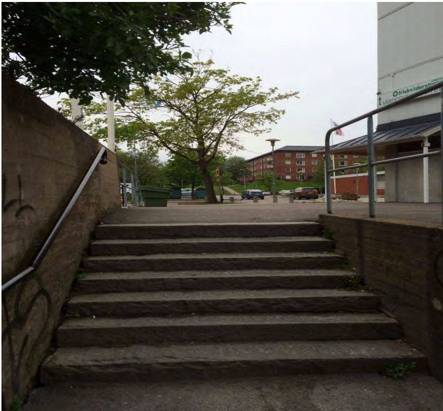
Figur 13. Den smala trappan från Spårvagnshållplatsen upp till torget som är inramad med väggar av betong. (Författarens egen bild)
