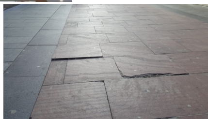
Figur 17 & 18. Dåligt underhållen fasad och markbeläggning på Fredsgatan
