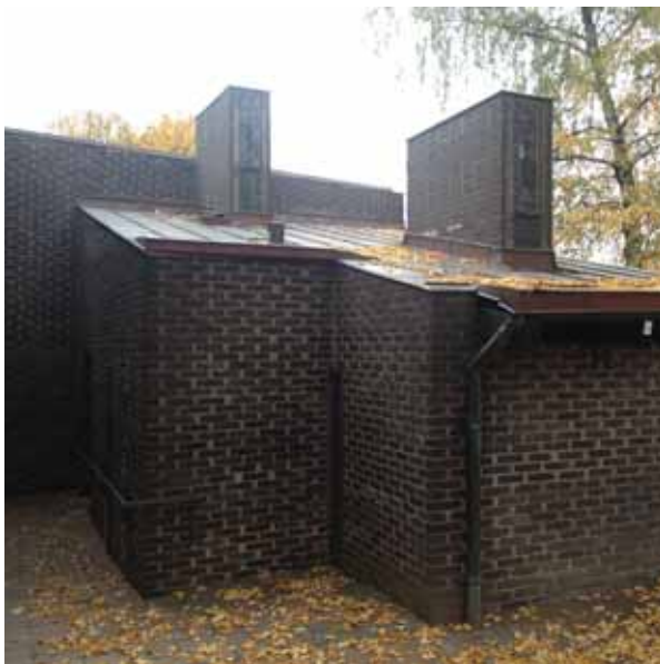
Entréparti med skylights
