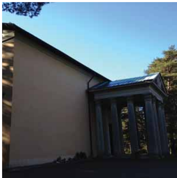
Tempelgavel möter byggnad
