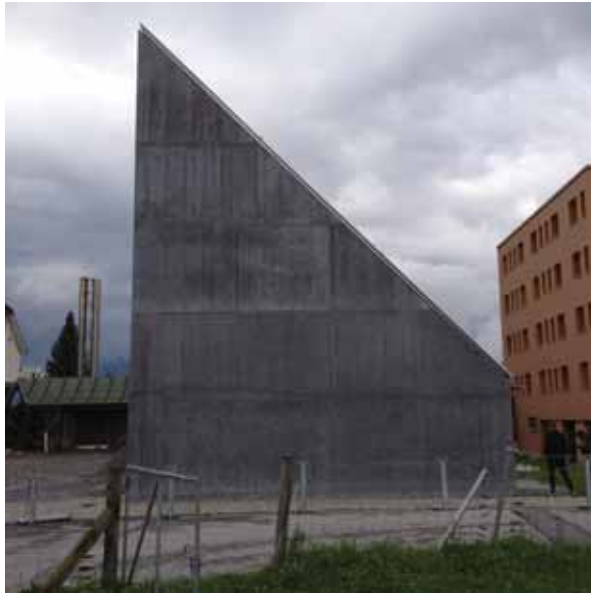
Fasad i betong
