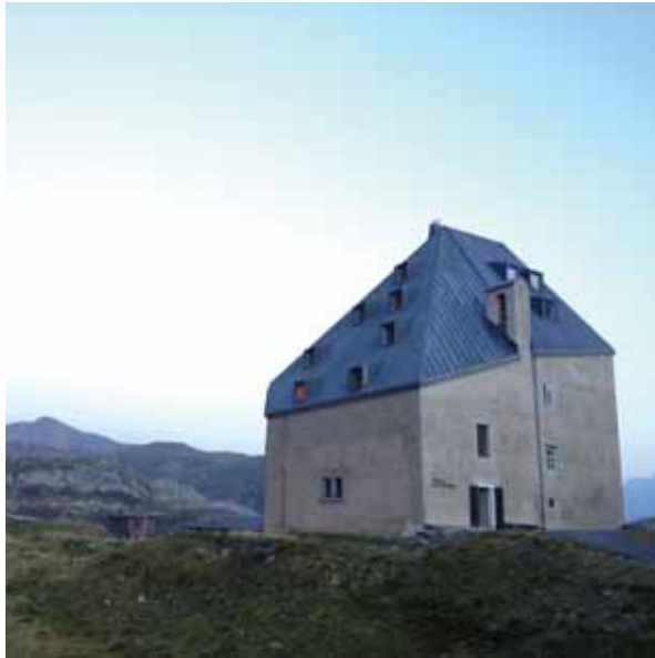
Blytak och puts
