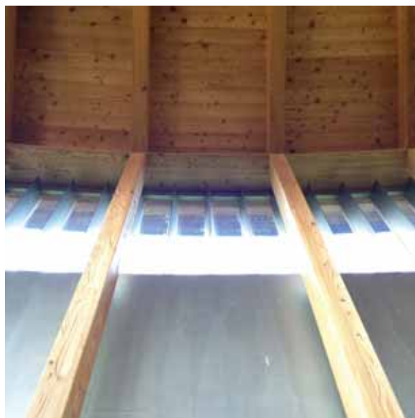
Fönster med solavskärmning
