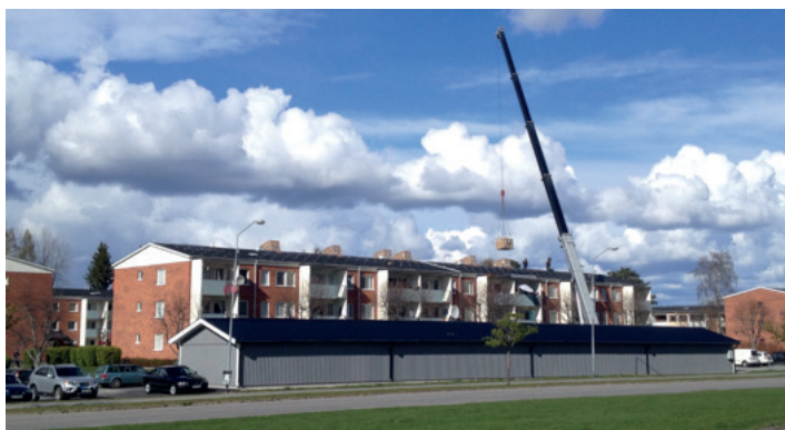
Figur 3: Ett miljonprogramshus får solcellsmoduler på befintligt tak.
