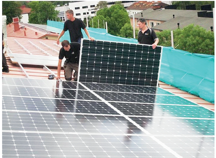
Figur 6: Prefabricerade solcellstak förväntas bland annat minska mängden arbete på tak och öka kvaliteten på installationerna.
