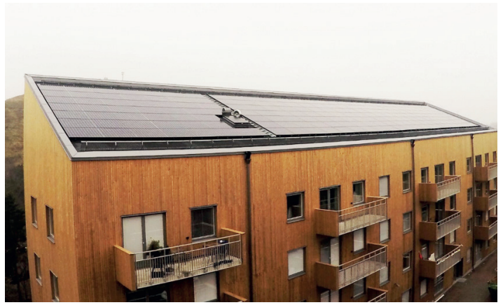
Figur 5: Ett tak utan ventilationsdon eller skorstenar kan ibland uppfattas som sterilt. Möjligheter till alternativa kanal-dragningar undersöks också i projektet.
