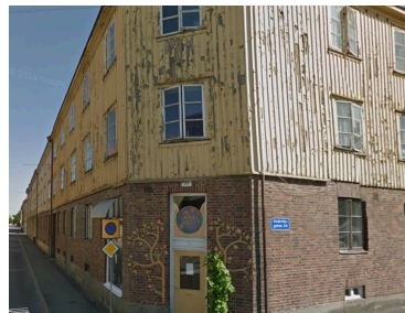
Figur 10 Landshövdingehus (Google street view, 2016)
