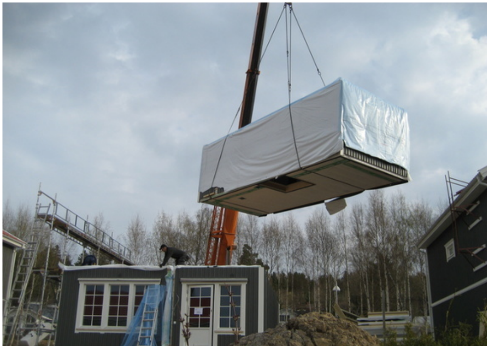
Bild 1: Färdigbyggda moduler som monteras ihop på byggplatsen.
