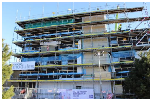
Bild 8, Byggställningar, plywood för trapphus i väntan på montering av glasfasad
