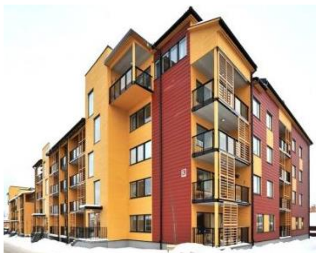
Figure 22: Project Kv Hyttkammaren in Falun (KLH Sverige, 2016b)
