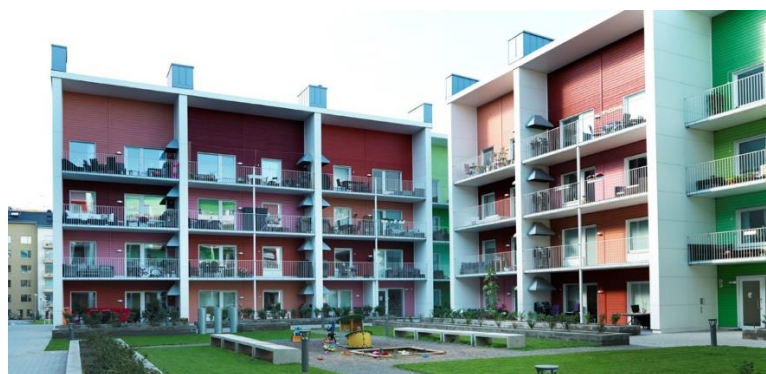
Figure 28: Project Hjortronstället in Sundbyberg (Lindbäcks Bygg, 2016a)
