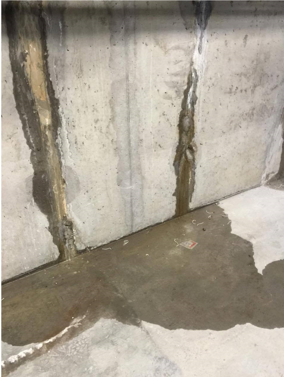
Figur 2.1 Vattengenomträngning i sprickor och fogar. Författarnas egen bild.
