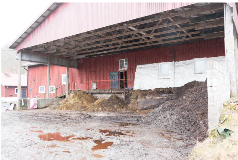
Figur 21. Gödselplattan vid stall D försedd med tak. Författarnas egen bild.
