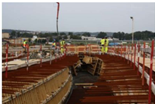
Figur 13. Armering och gjutning, (P-O Svahn, 2016).
