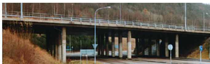
Figur 4-4. En plattbro (Trafikverket, 2008b). Återgiven med tillstånd.
