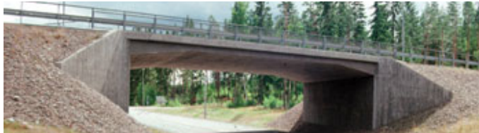
Figur 4-1. En plattrambro (Trafikverket, 2008b). Återgiven med tillstånd.
