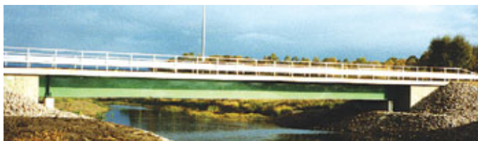
Figur 4-2. En stålbalkbro (Trafikverket, 2008b). Återgiven med tillstånd.
