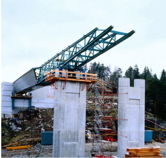
Figur 8 Pågående lansering av bro med lanseringsnos av fackverk längst fram (Svahn, 2016). Återgiven med tillstånd.
