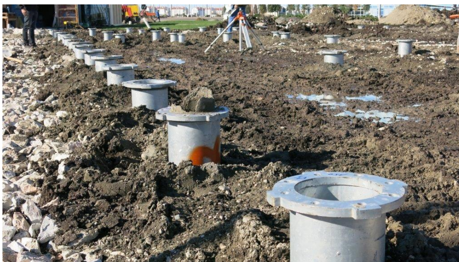
Figur 5.3. Installation av KRINNER skruvfundament KSF E140x3000 (Johansson, 2016).
