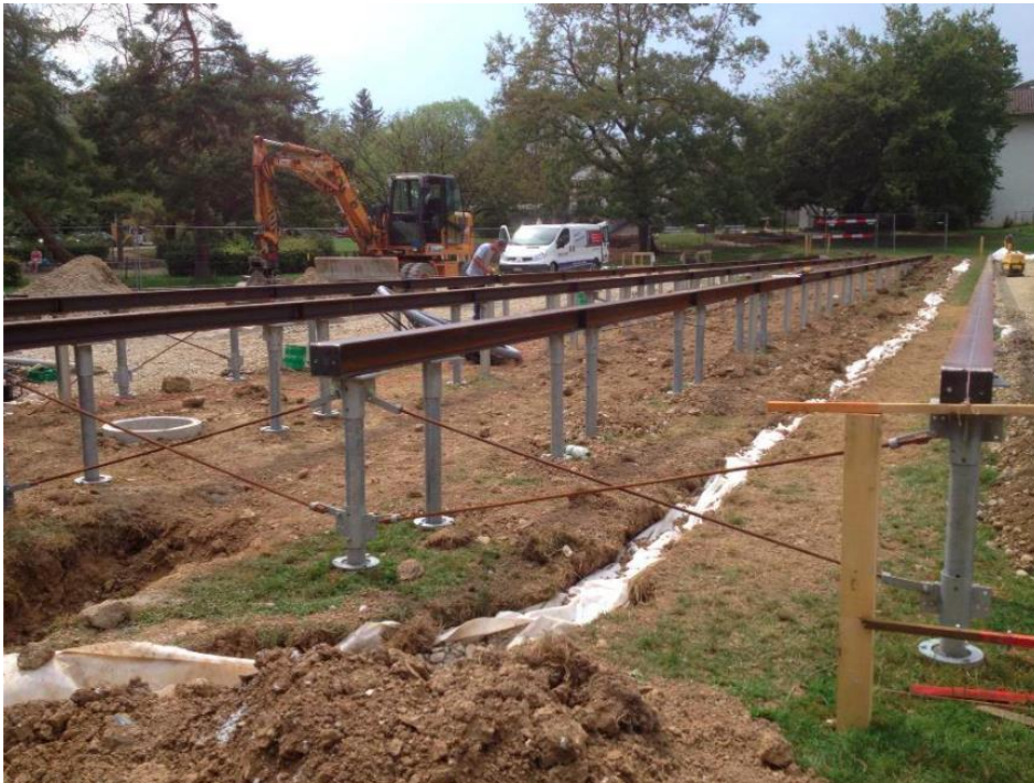
Figur 5.4. Förlängningsrör och balkar i lätt sluttande terräng (Johansson, 2016).
