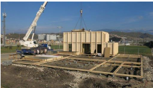
Figur 5.5. Modulerna lyfts på plats (Johansson, 2016).
