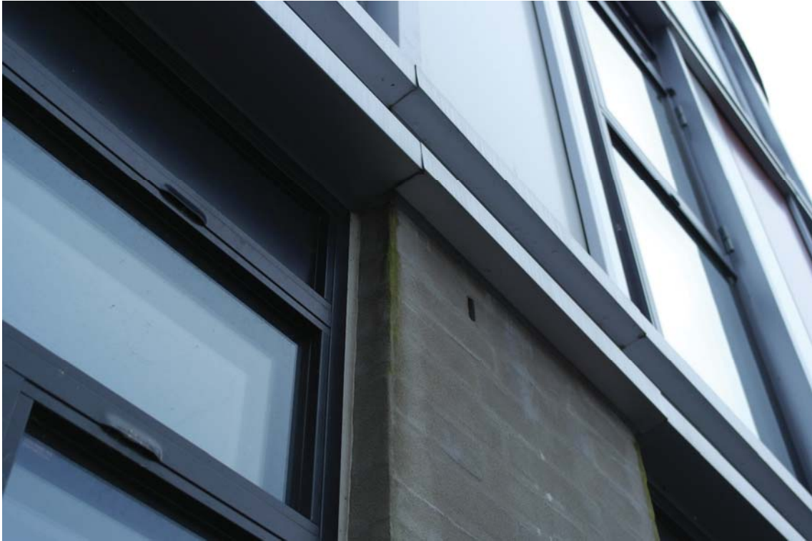
Figur 4. Möte skalmur och Parocement över fasadöppning Hillerød Danmark. Foto: Författarna.
