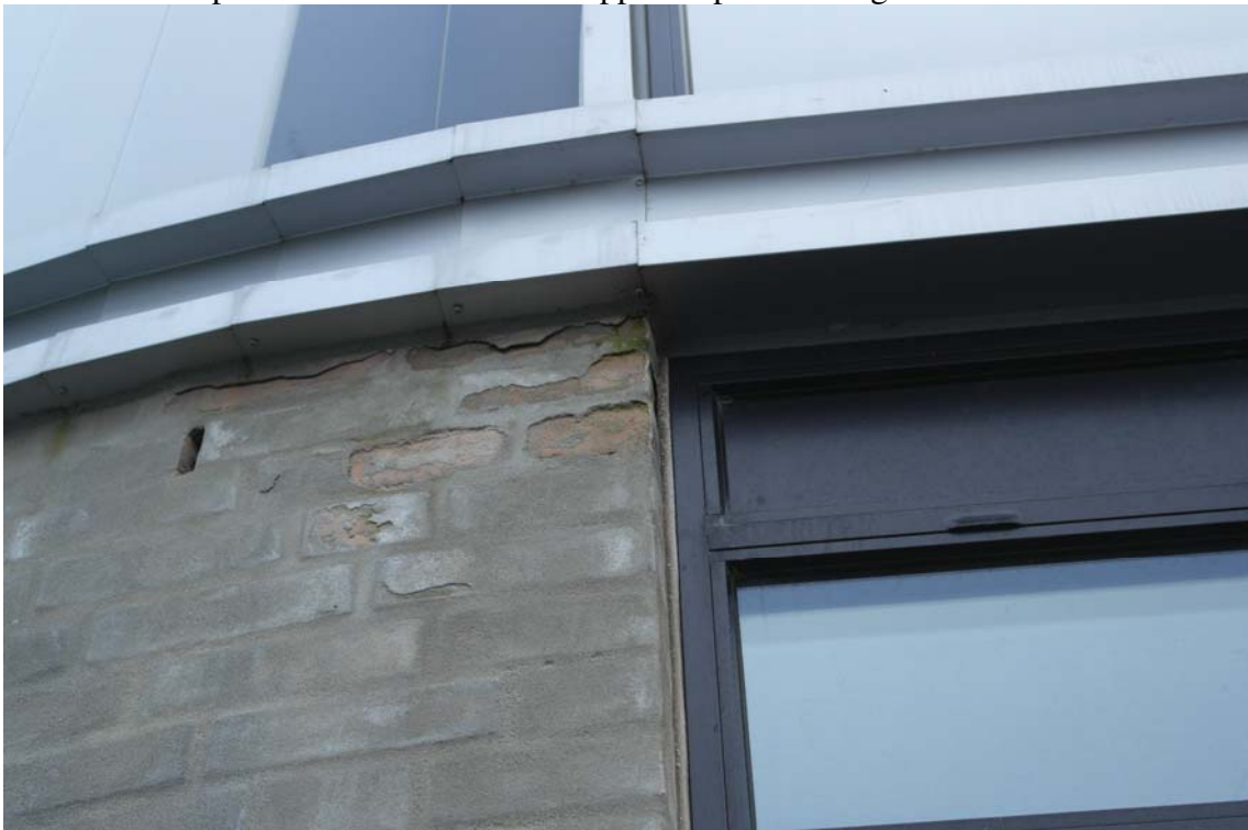
Figur 5: Möte skalmur och sandwichelement vid rundat hörn. Foto: Författarna.
