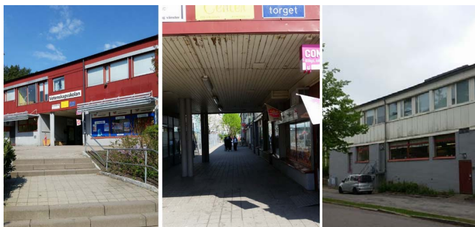
Figur 4.7: Den röda verksamhetsbyggnadens exteriör.
