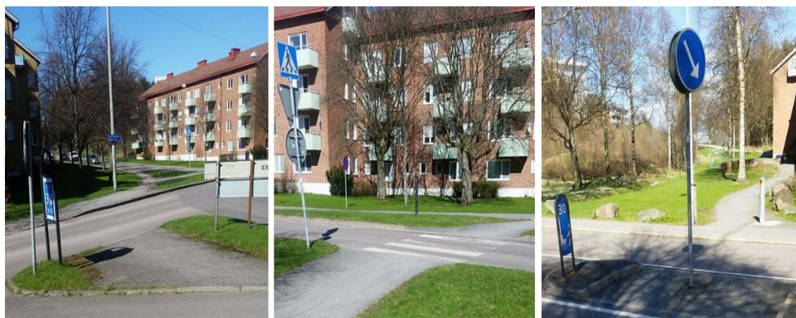
Figur 4.10: Tydliga (i mitten) men även otydliga övergångsställen (till vänster och till höger).
