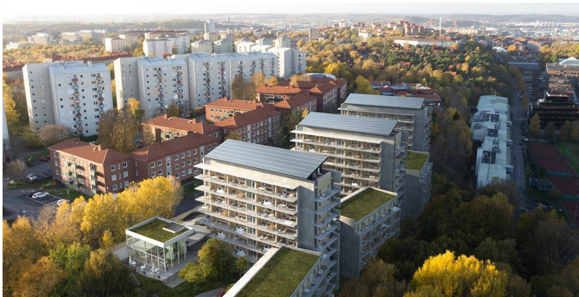
Figur 13: Flygbild på Brf Viva. Illustration: Riksbyggen. Tillstånd att publicera givet av Riksbyggen.
