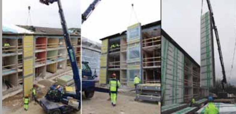
[14] Byte av fasad till prefabricerad passivhusvägg. Exempel från Brogården. Foto: Skanska (2014)
