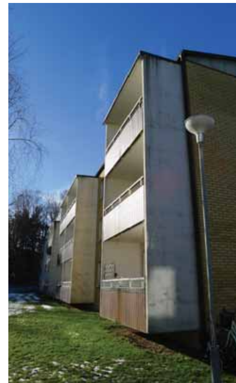
De utskjutande väggarna som bär balkongerna är en stor köldbrygga
