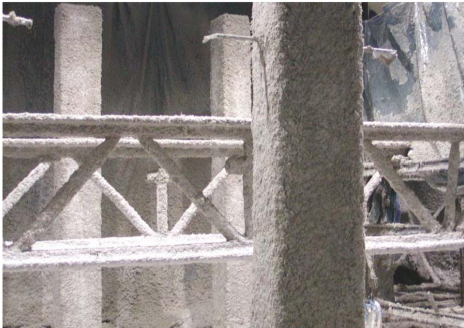
Figur 2 Stålstrukturer inklädda i SFRM [II]
