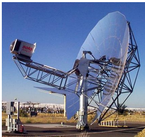
Bild 2.7 Framsida Cleanergys CSP disk
