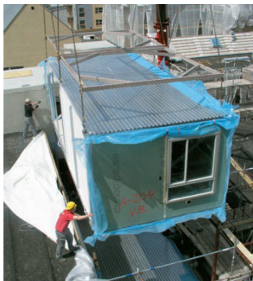
Figur 3.5 Slutmontering på byggplats
