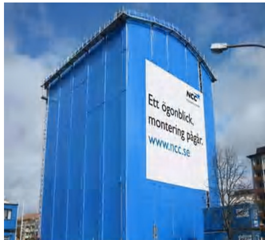
Figur 6.4 Väderskyddande monteringshall
