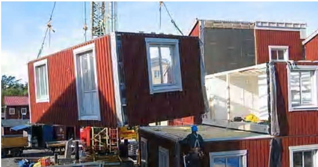
Figur 5.3 Volymelement lyfts på plats
