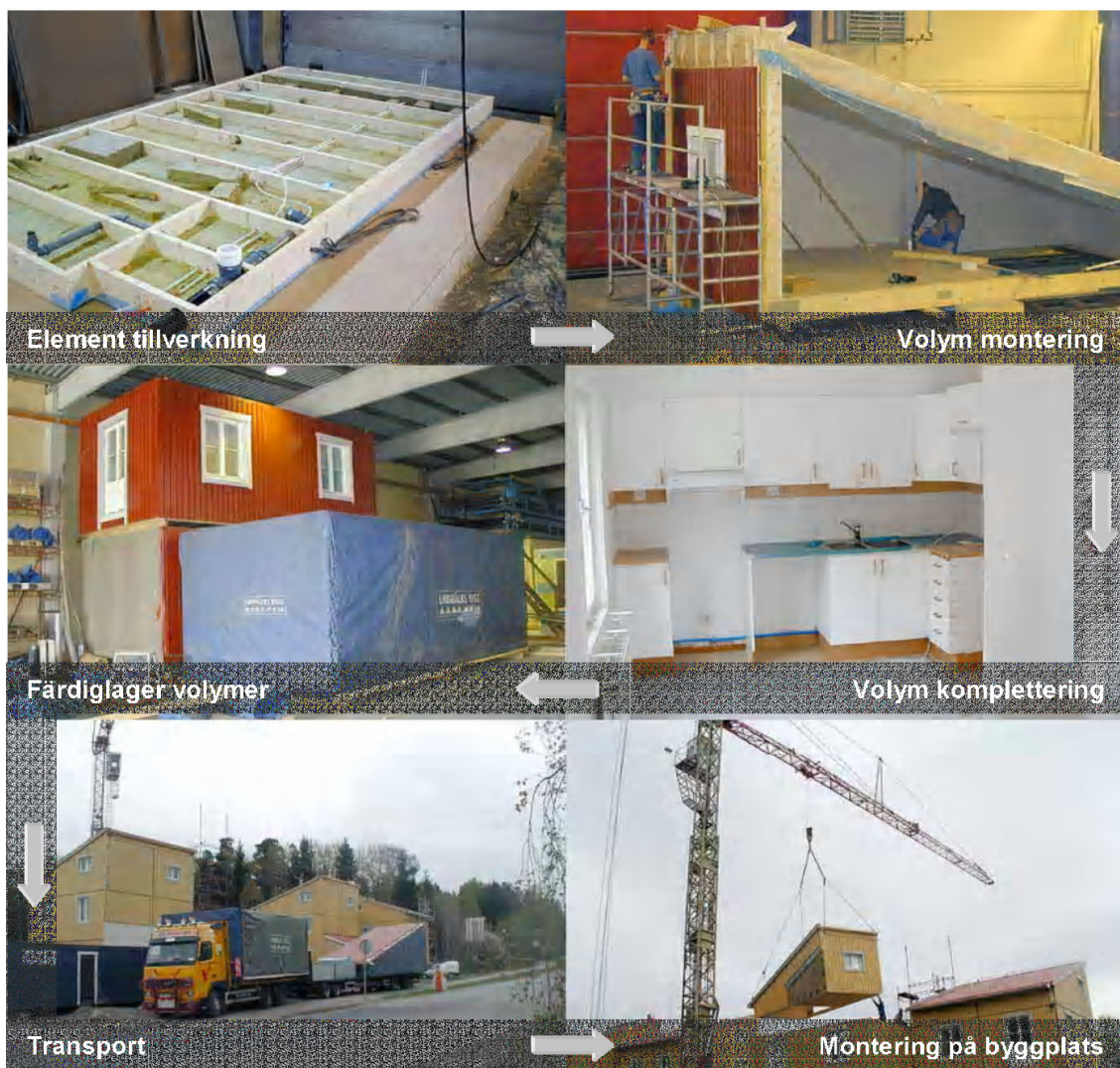
Figur 2.1 Exempel på tillverkningsprocess av volymmoduler
