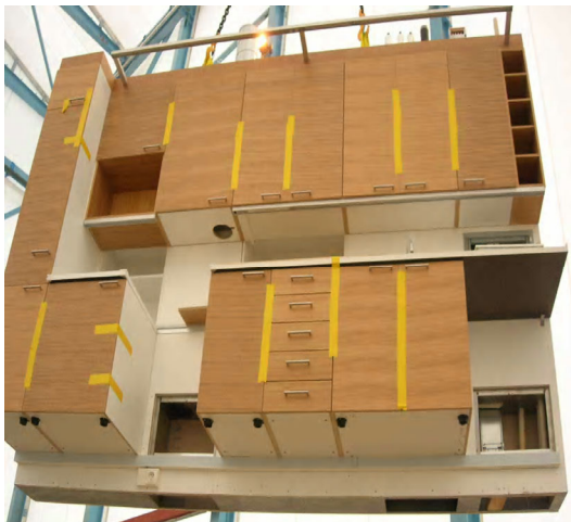
Figur 6.3 Fabrikstillverkat kök lyfts på plats
