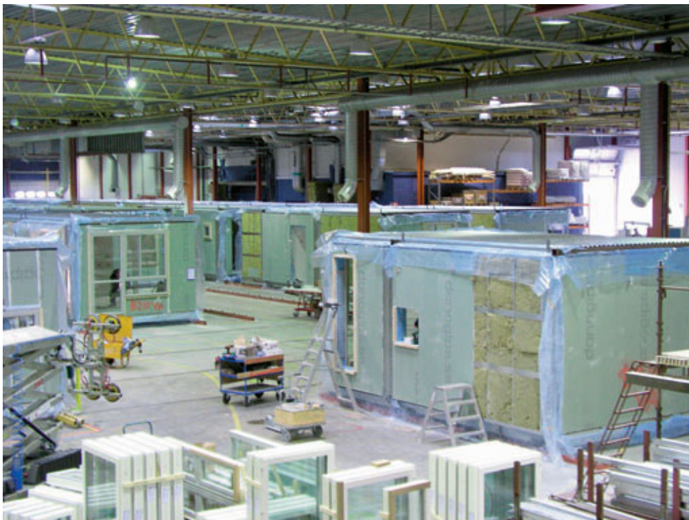
Figur 3.3 Volymmoduler kompletteras till färdiga lägenheter i fabriken
