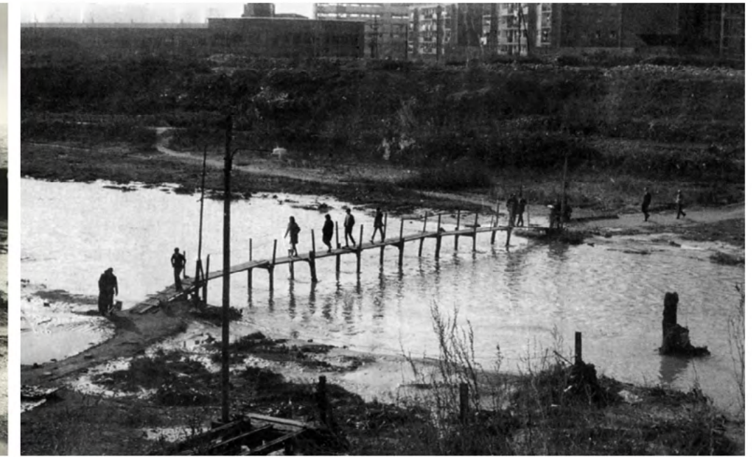
(b) Besós flooding 1962-Archivio historico de l'Ajuntamnet de Barcelona
