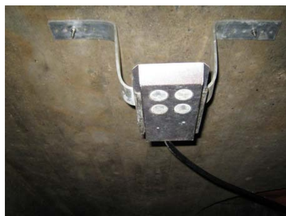
Figur 7: Ekolod för nivåmätning över skibord
