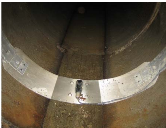
Figur 6: Flödesmätare i bräddledning
