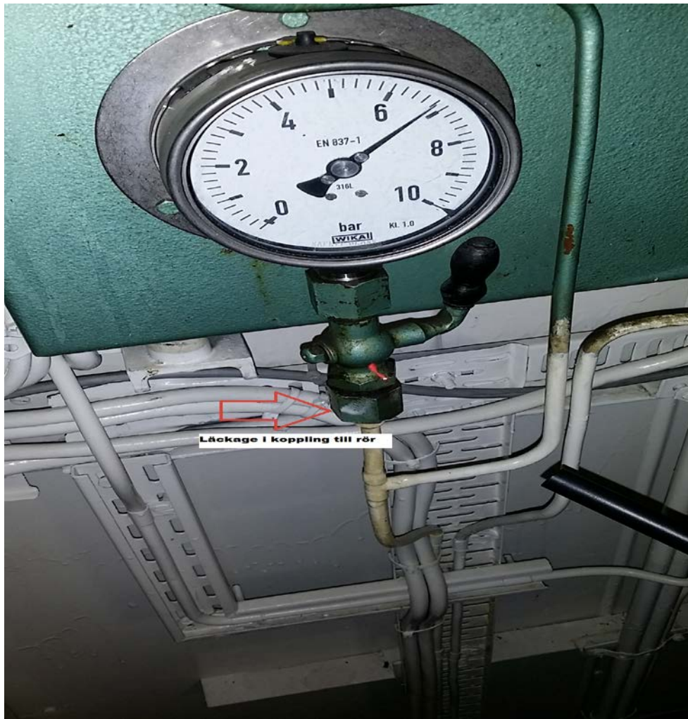
Figur 5. Läckage i koppling (Ståhl, 2015)
