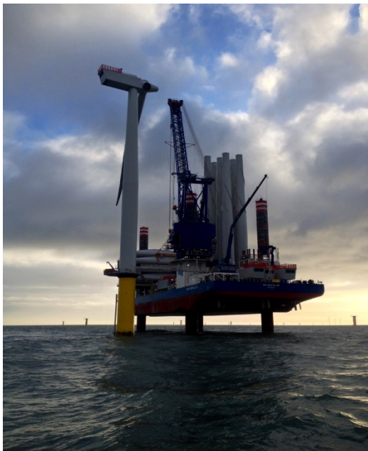
Figur 10 – Visar hur SEA WORKER är ”upphissad” i luften och kan med hjälp av kranen placera turbinens övre delar som skall på plats på fundamentet.
