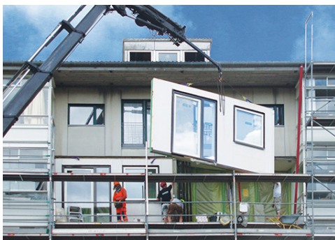
figure 17. Egedalsvænge construction process
