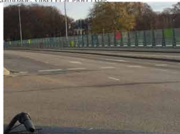
Bild över dagens bullerskydd och markmaterial
