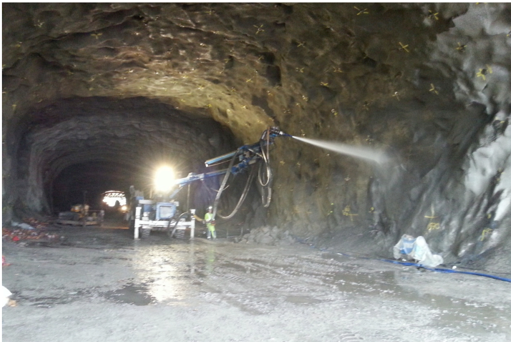
Figur 2.2 Sprutbetong sprutas på berget i tunneln till väg E6 i Tanumshede. Bild: K.Andersson
