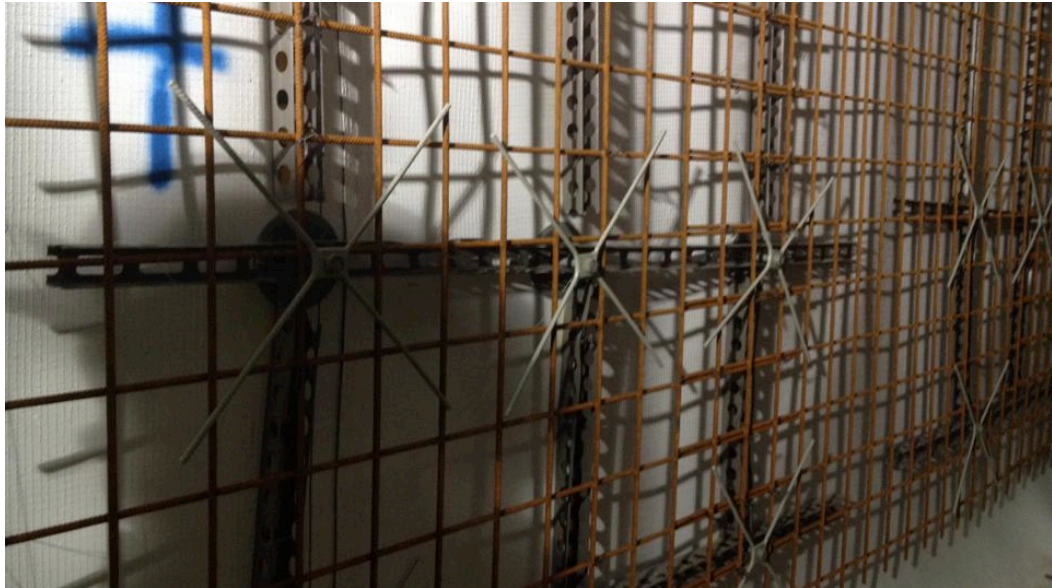
Figur 2.6 Armeringsnät monterat med kryss på distansskenor, utanpå membran. Bild: K.Andersson
