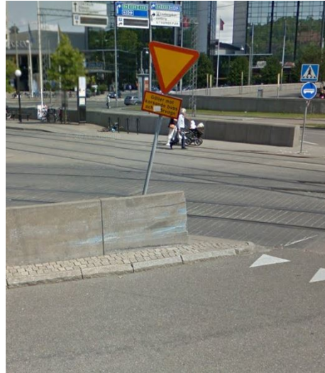
Figur 3-4: Påkörd betongkant vid snäv kurva Korsvägen.
