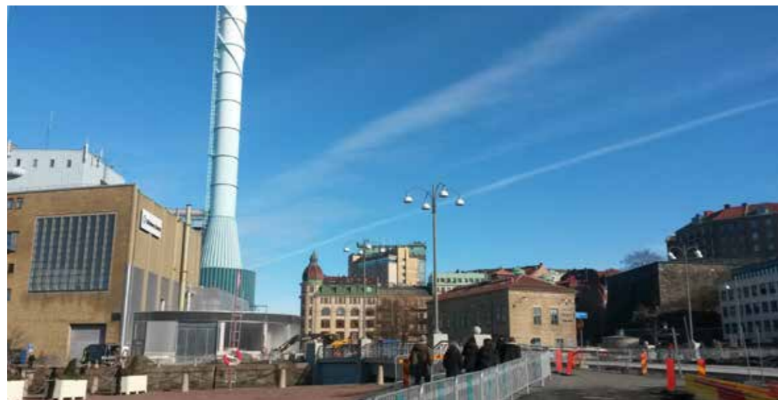
Bild 50. Trappning av volym ger ödmjukt förhållande till övrig bebyggelse kring Esperantoplatsen.
