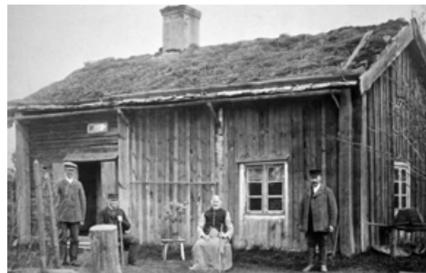
Delvis panelbeklädd timmerstuga med Torvtak ovanpå en näverbädd i Svennevad, sekelskifte, FOTO: Gustaf Ferdinand Hallberg 60
