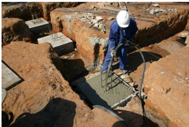
fig. 56 Pouring concrete foundation
